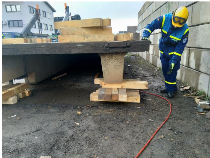
Anheben von Lasten.
